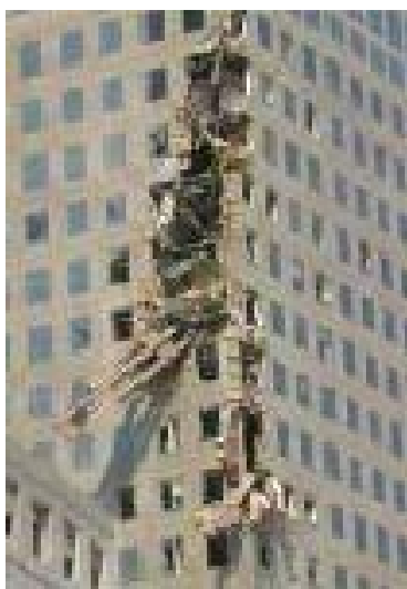
Bild 1: Aufgespiesste Säulen als Nachwirkung
